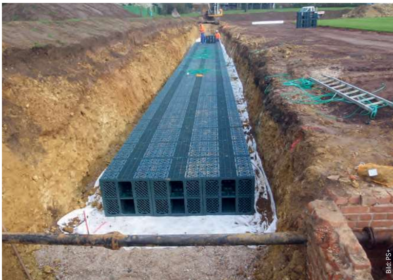
Kunststoffsickerblöcke helfen dabei, Niederschlagswasser nach und nach ins Grundwasser abzuleiten.
